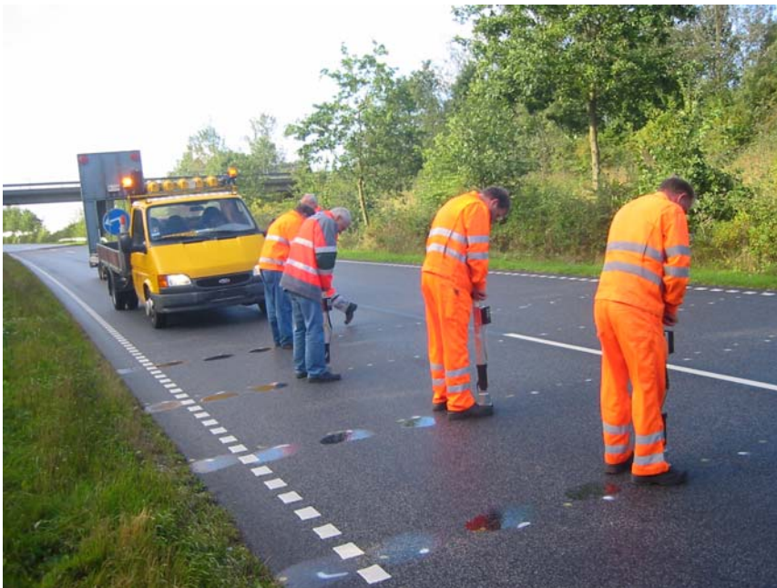
Måling med SOBO20 på målestrækningen Ldv. 509
