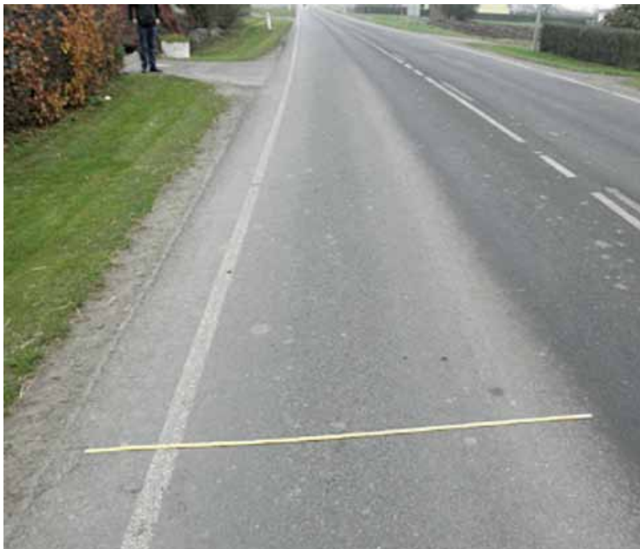
Figur 2. Saltlagen er tydeligt ikke kommet ud på de yderste 2 meter af vejbanen.
