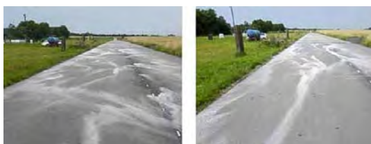
Figur 1. Eksempler på synlig fordeling af salt efter en passage af en saltbil.
